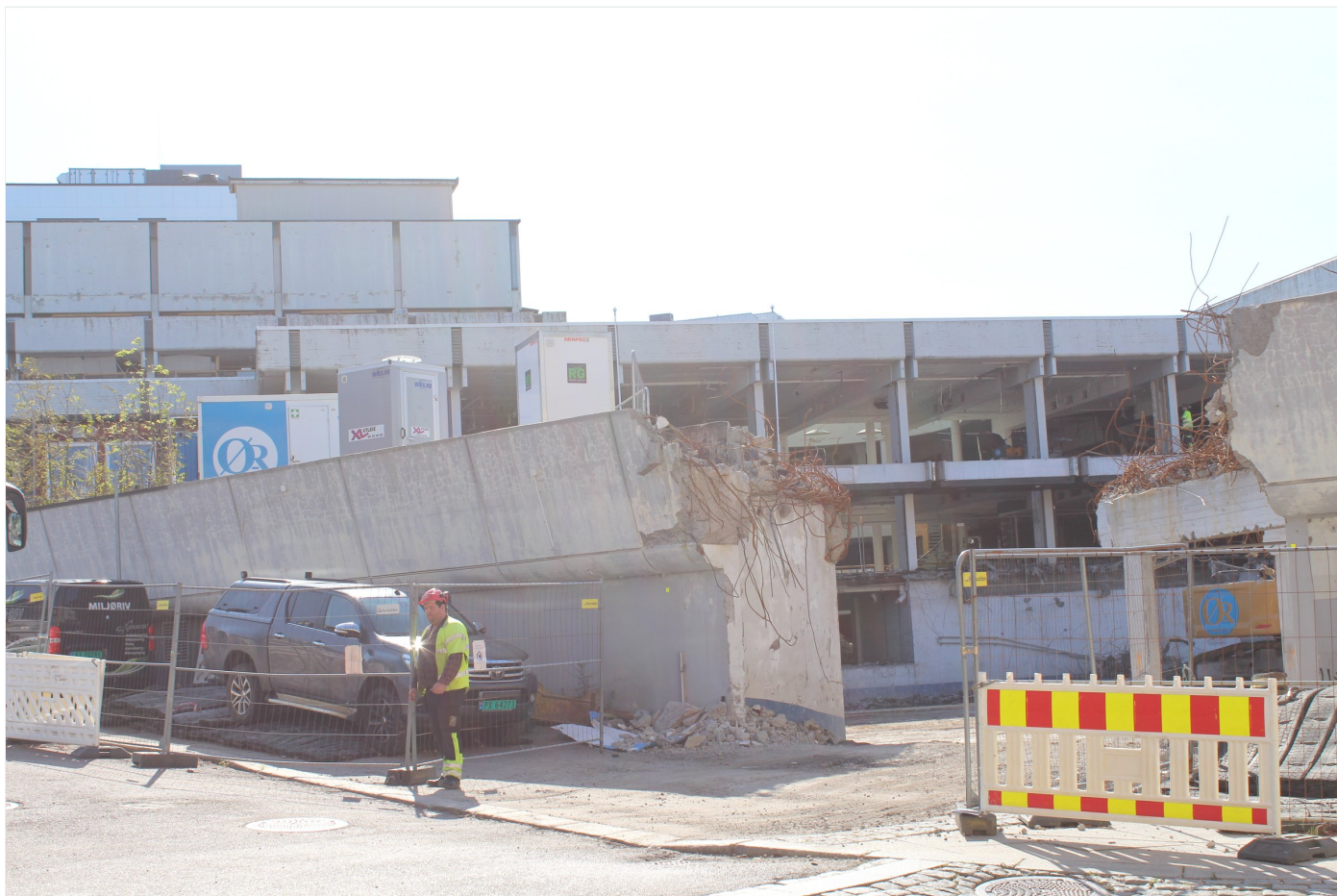
Rivingen av det gamle senterbygget i Dronningkvartalet, fotografert september 2026.
