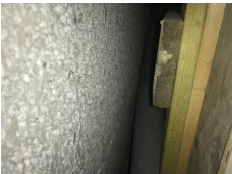
Vegg til badet er foret ut fra grunnmur av lettklinker betong så man kan se mellom grunnmur og vegg til badet fra teknisk rom
